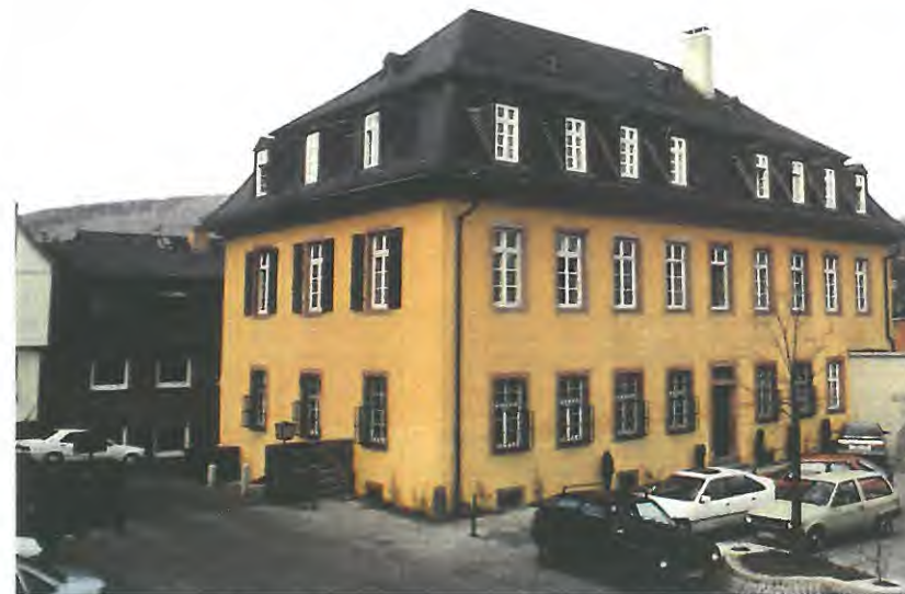
Ehem. Mainzer Rentamt (jetzt Amtsgericht), Gerichtstraße 2
