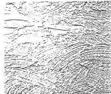
Kellenputz mit dem Quast abgezogen
